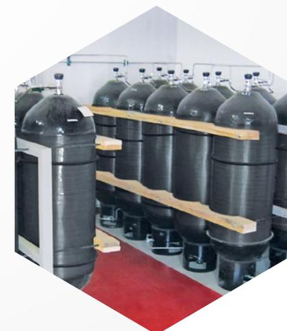
Баллоны для систем пожаротушения
