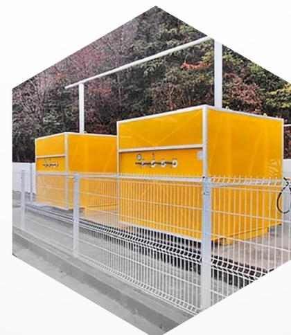
Стационарный блок аккумуляторов газа для АГНКС
