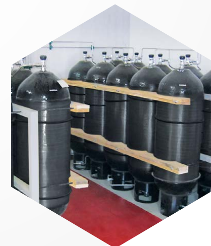
Баллоны для систем пожаротушения
